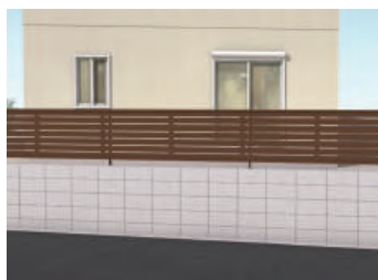
ブロック+フェンスに
